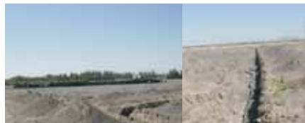
Ein Wasserversorgungsnetz wurde vergraben
