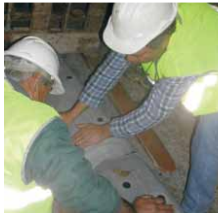
Die ersten COMPOair S Rohre werden verlegt
