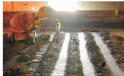
Vorbereiten der Streifenfundamente
