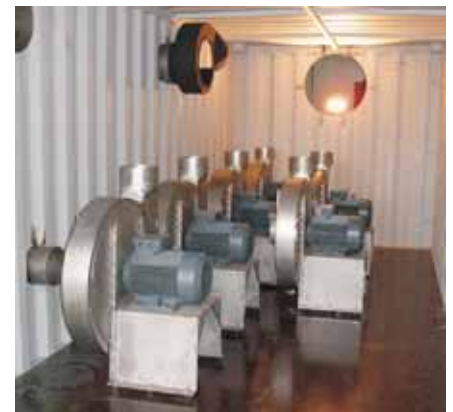
COMPOtainer im "Bauzustand"
