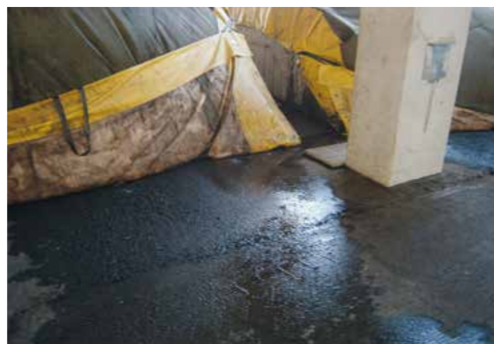
Woda technologiczna może wydobywać się z boku spod membrany. Może ona emitować więcej odorów, niż sama przyzma kompostowa
