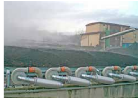
1997 wurde auf der ersten Kompostanlage in Österreich das Belüftungssystem „COMPOnent“ installiert. Heute wird österreichweit auf 15 Anlagen eine Verarbeitungskapazität von mehr als 160.000 Tonnen Klärschlamm pro Jahr kompostiert.
