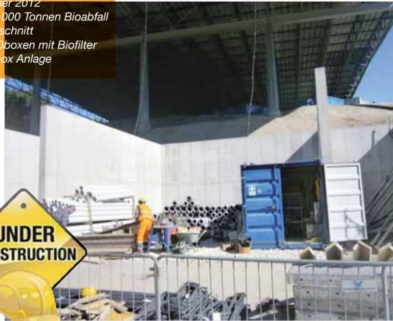
Der Vorteil der Rotteboxen liegt darin, dass der geruchsintensive Abbau der ersten Rottewochen in einem geschlossenen System mit kontrollierter zweistufiger Abluftbehandlung (Wäscher und Biofilter) stattfindet.
