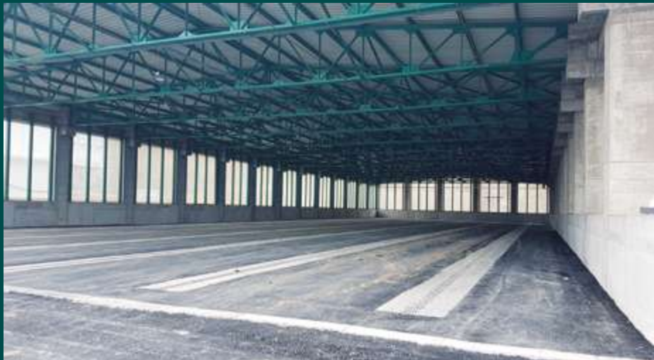
Instalación de compostaje terminada en la planta de Trípoli.
