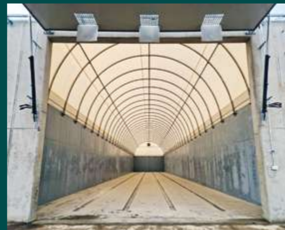
Die Boxen verfügen über hydraulische, leicht bedienbare Tore.
