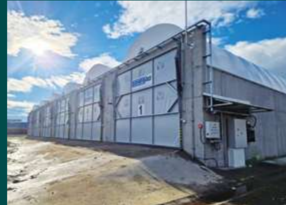
Abfälle werden in geschlossenen Boxen kompostiert.
