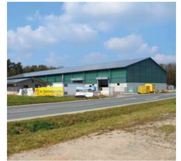
Die neue Komposthalle mit Photovoltaikdach.
