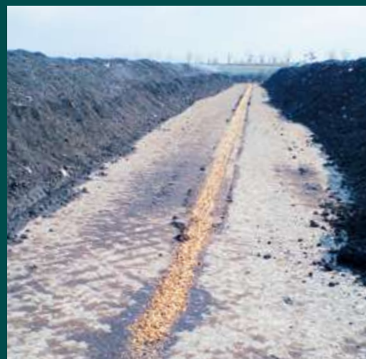
Ein Belüftungsstrang auf der Kompostanlage.
