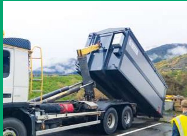
Entladen des CSC-Containers an der Kompostierstelle.
