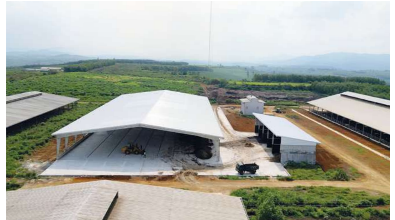
Die Kompostanlage in Phú Yên ist überdacht, um ganzjährig bei jedem Wetter Kompost produzieren zu können.
