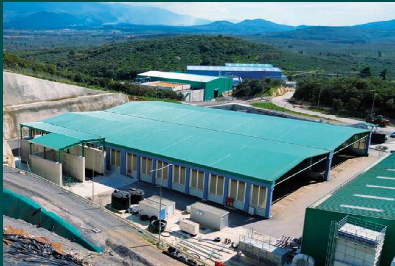
Anlage in Kalamata.
