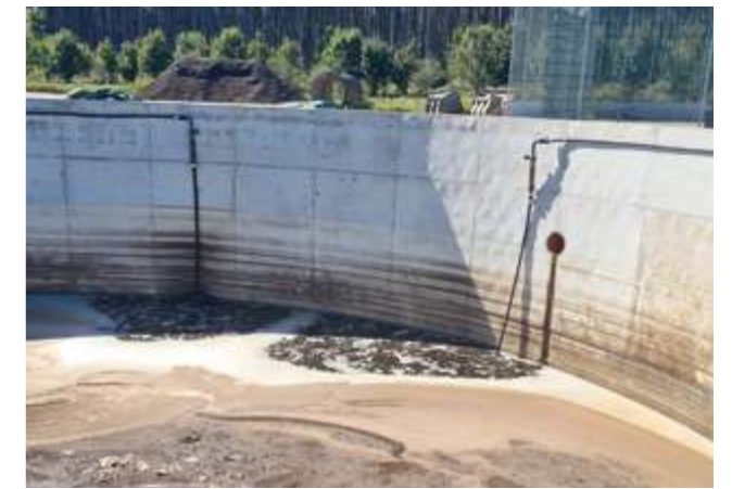
Belüftung zur Aerobisierung des Sickerwassers.
