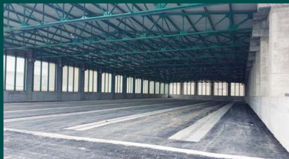
Eine fertige Komposthalle auf der Anlage Tripoli.
