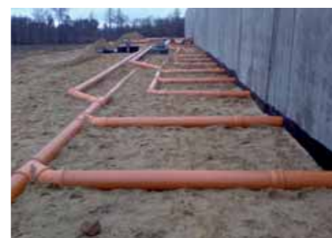
Rohrleitungsbau von den Rotteboxen zum COMPOtainer
