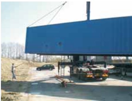
Entladung und Positionierung des COMPOtainers
