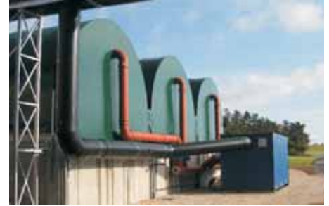
betriebsbereiter COMPOtainer COMPOboxanlage Chaumont
