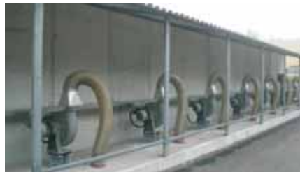
Belüftungsventilatoren für Saug- und Druckbetrieb
