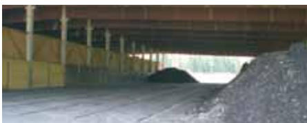
Rotttehalle mit nachgerüsteten Belüftungssträngen
