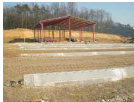
Belüftungsfläche bereit zum Asphaltieren
