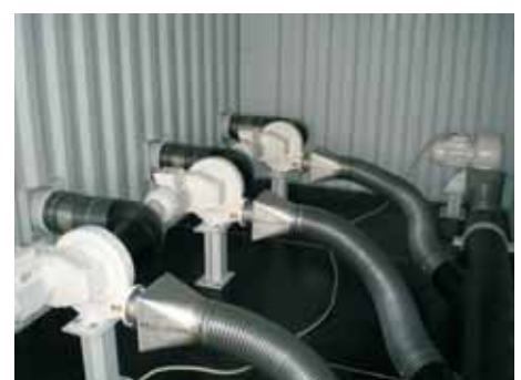
Saugventilatoren im COMPOtainer
