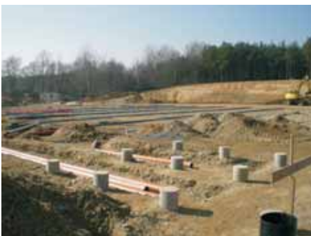
Rohrleitungsbau zum COMPOtainer
