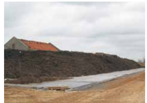
Derzeit wird noch im kleinen Stil mit offenen Mieten kompostiert. In der Endausbaustufe soll der Rotteprozess völlig geschlossen werden um Geruchsemissionen zu verhindern.
