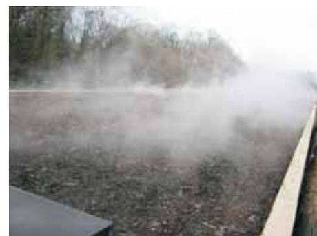
**Der für 90.000m<sup>3</sup> Abluft ausgelegte Biofilter reinigt die Abluft**
