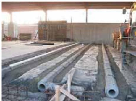
**Für die Belüftung wurden COMPOair S Belüftungsrohre verwendet. Dadurch wurde an Bauhöhe gespart.**
