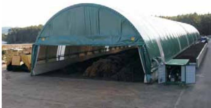
belüftete eingehauste Intensivrotte mit COMPOTainer und Biofilter
