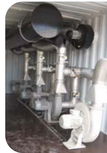
Der COMPOtainer ist eine Lüfterzentrale, die vollständig vorinstalliert auf der Anlage angeliefert wird. Elektrisch und Lufttechnisch anschließen – fertig! Damit verkürzt sich die Realisierungszeit und es reduzieren sich die Schnittstellen zwischen den Baugewerken.
